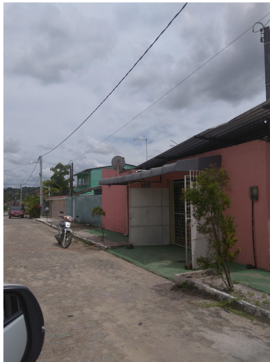
3.1. Fachada do Serviço
