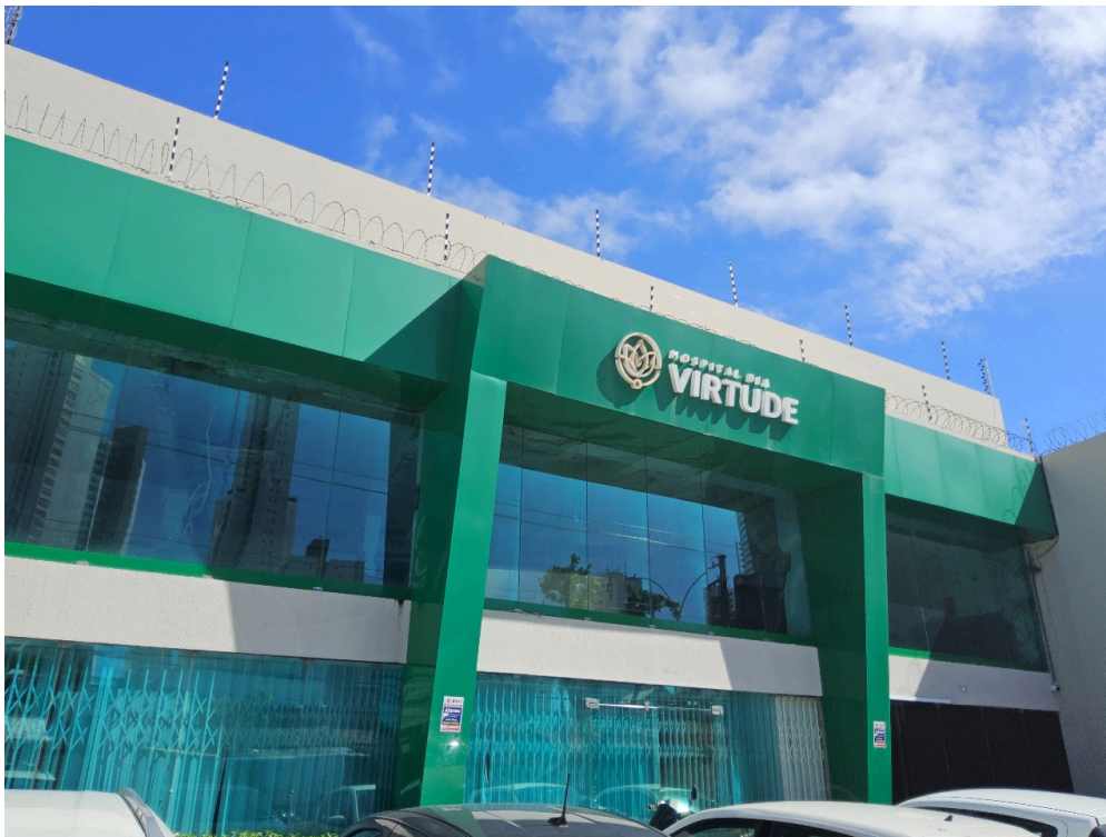
DADOS CADASTRAIS - Registro Fotográfico da Fachada
