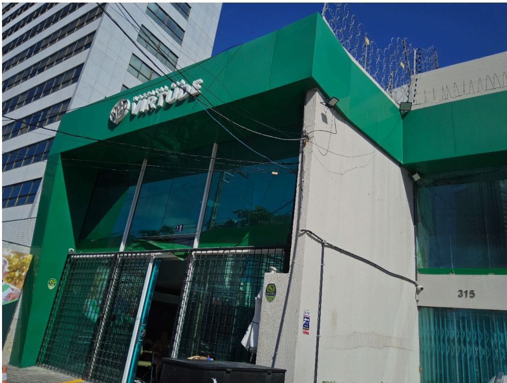
DADOS CADASTRAIS - Registro Fotográfico da Fachada
