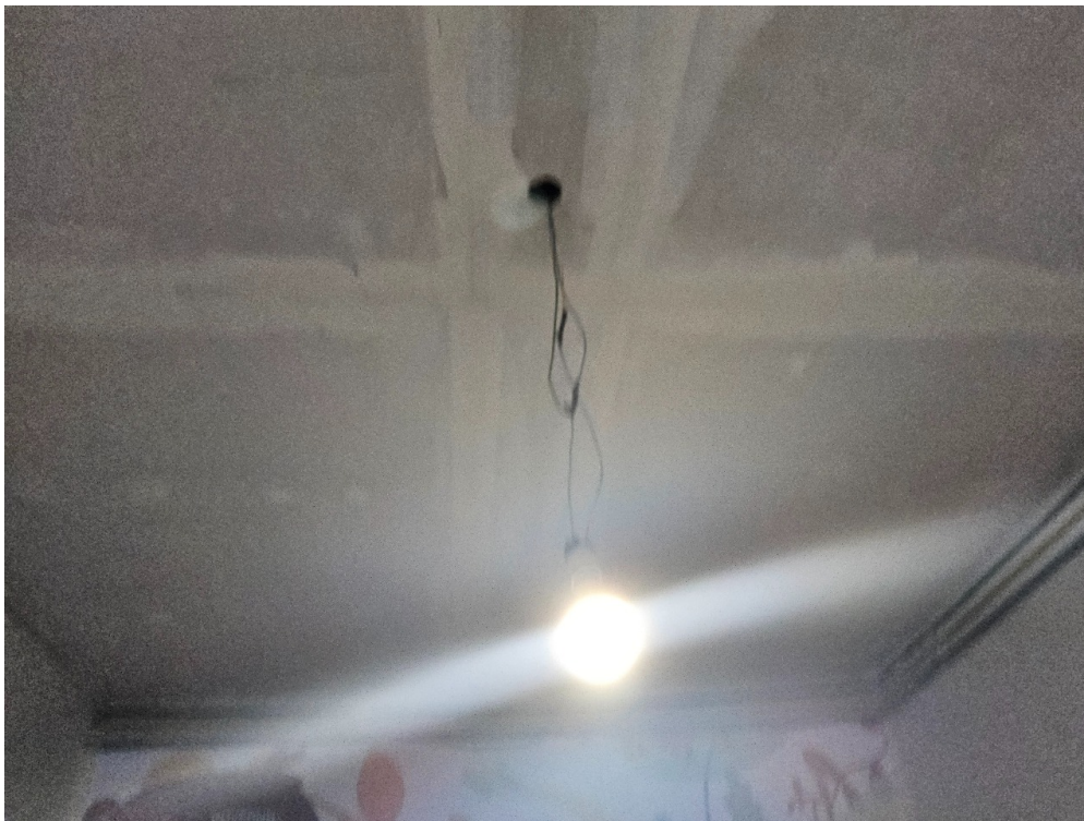
CONDIÇÕES ESTRUTURAIS DO AMBIENTE FÍSICO - GERAL - Especificar:
