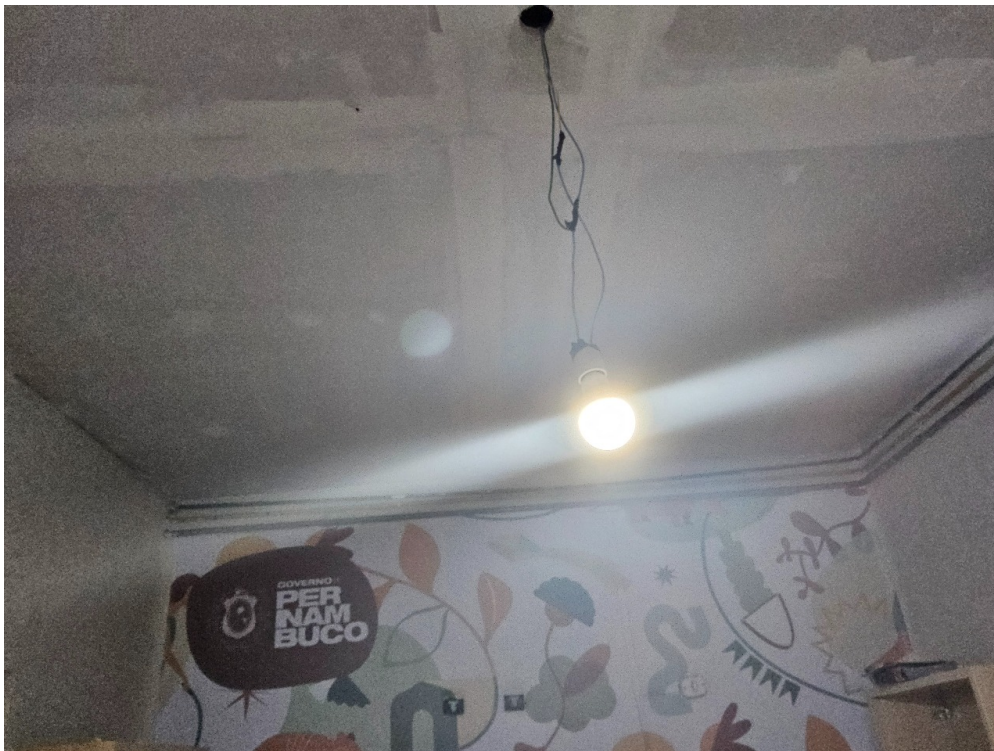
Imagem da 1ª constatação. Substituição da cobertura de gesso do teto.
