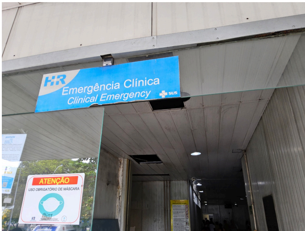
ENTRADA DA EMERGÊNCIA PEDIÁTRICA - fachada da recepção compartilhada
