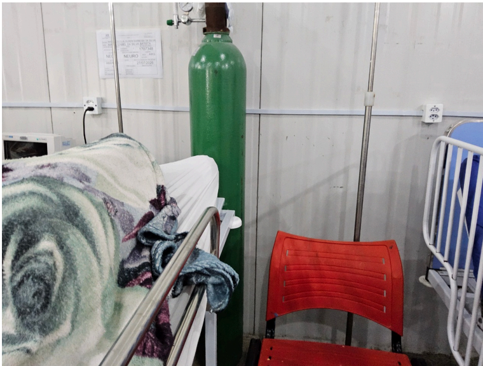
CILINDRO SEM FIXAÇÃO
