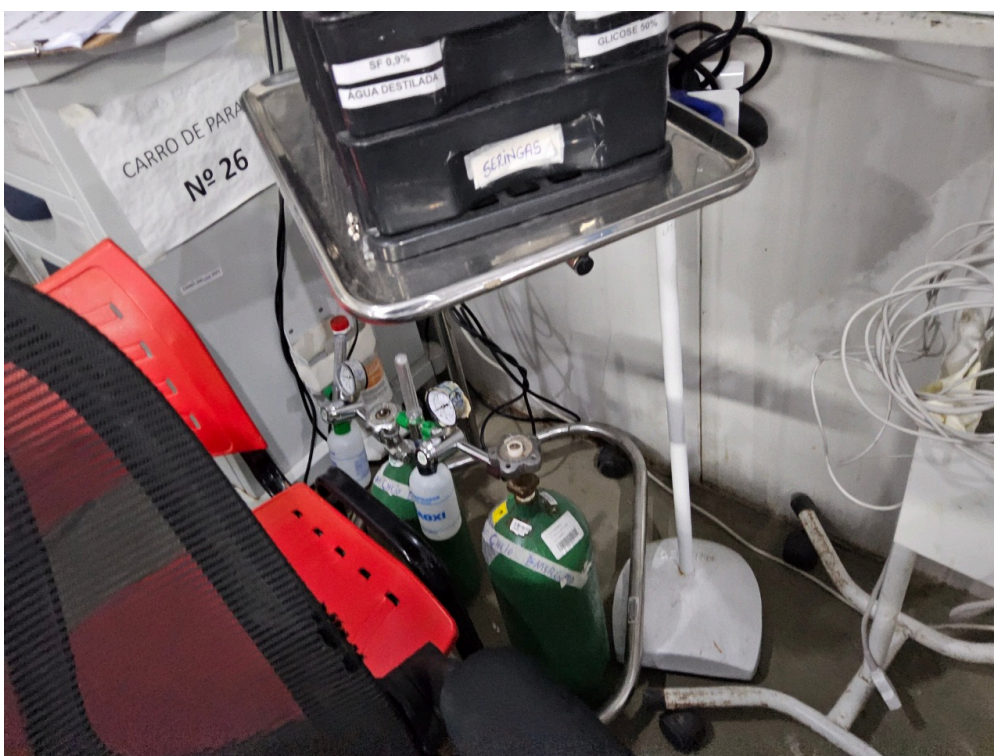
CILINDROS SEM FIXAÇÃO
