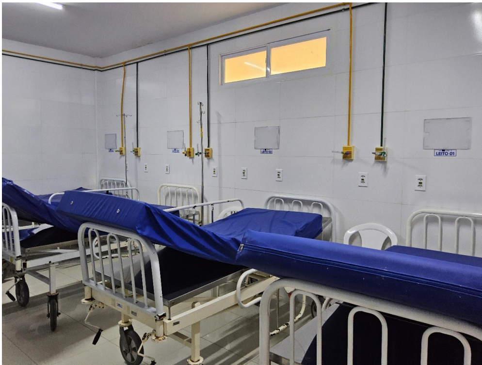
ESTRUTURA DA UNIDADE - Sala de Observação
