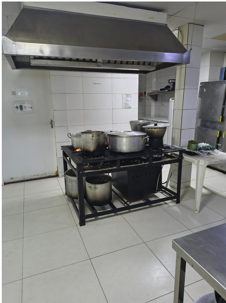
Cozinha do refeitório
