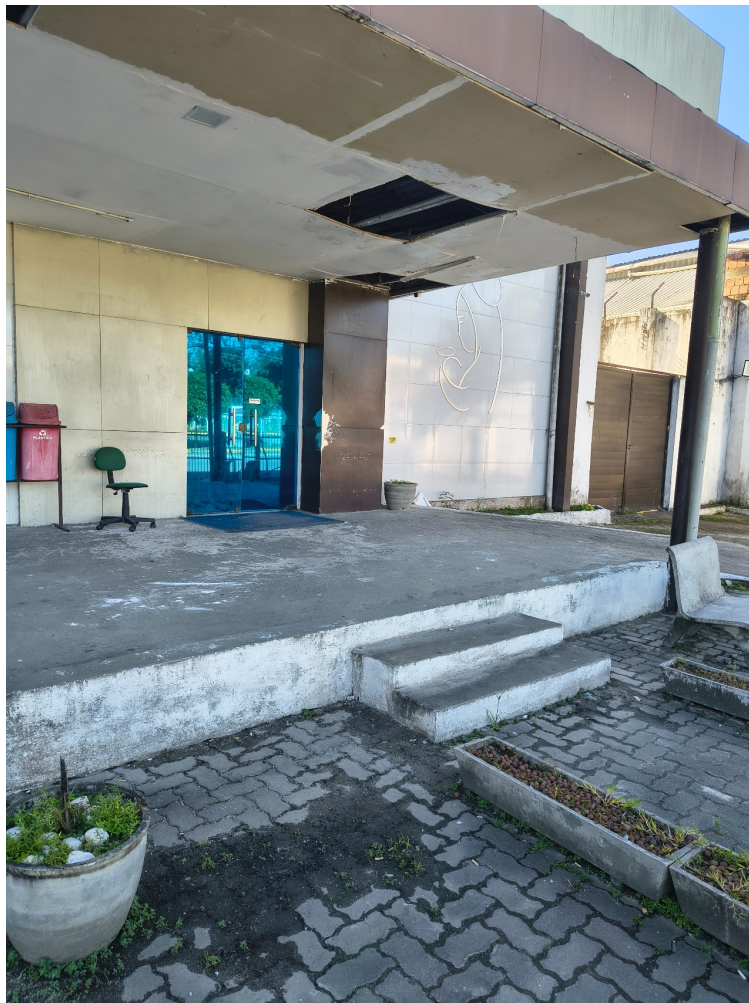
DADOS CADASTRAIS - Registro Fotográfico da Fachada
