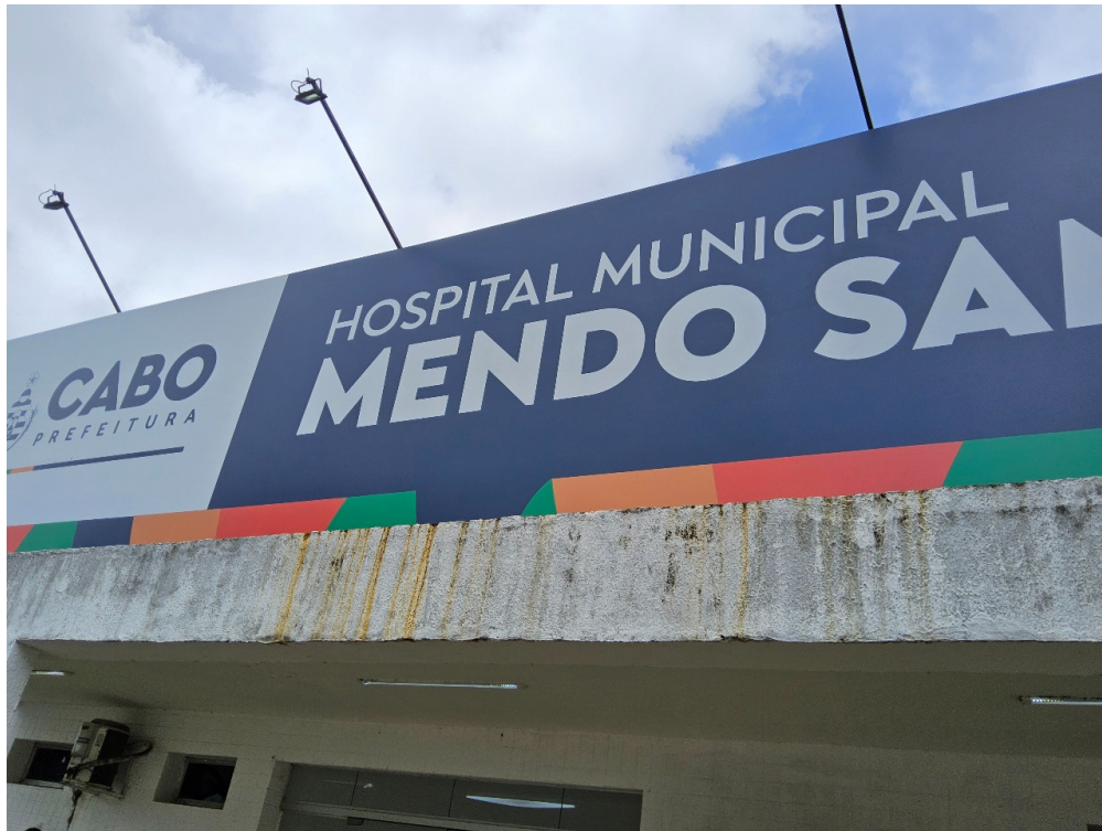
DADOS CADASTRAIS - Registro Fotográfico da Fachada
