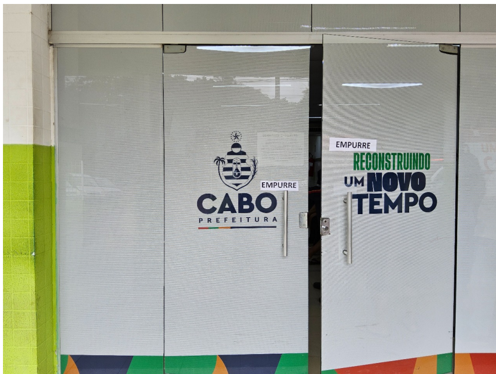
DADOS CADASTRAIS - Registro Fotográfico da Fachada
