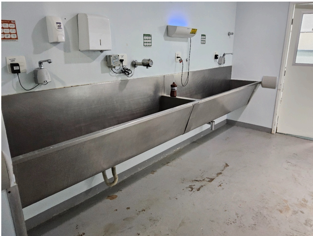
Centro cirúrgico obstétrico
