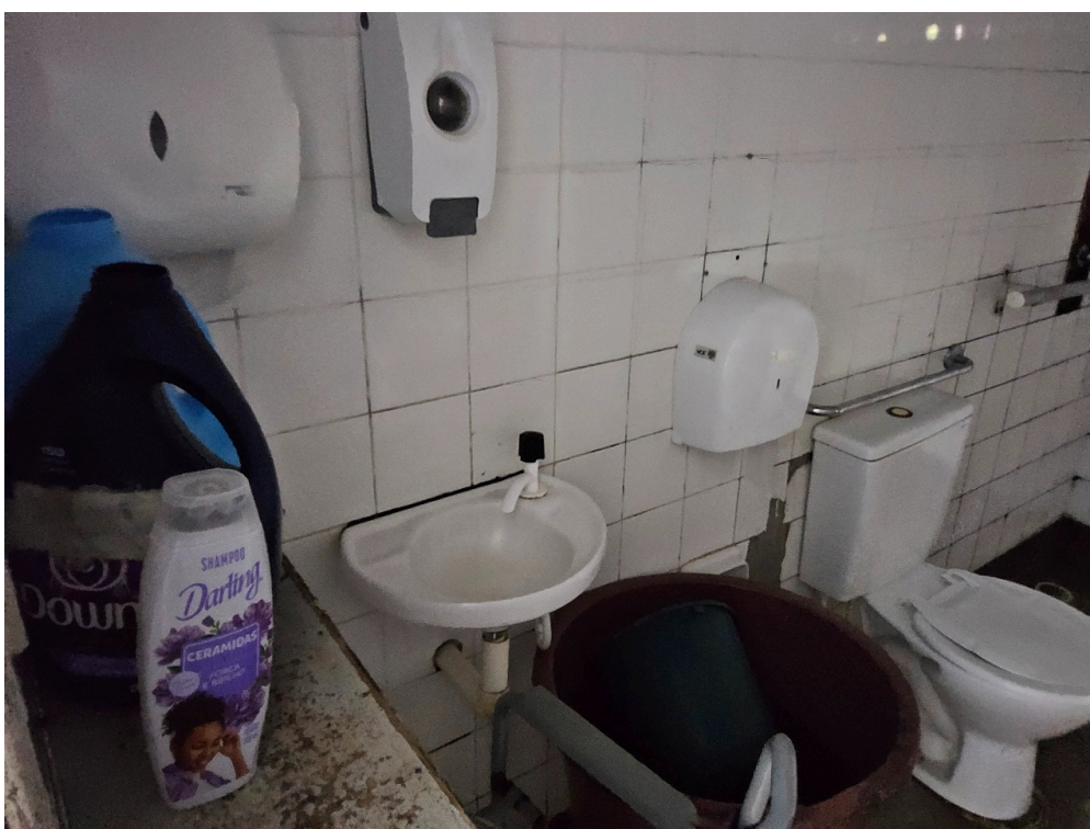
SALA DE OBSERVAÇÃO ADULTO - Sanitário anexo
