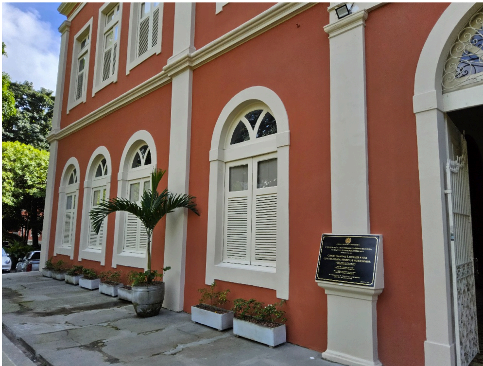
DADOS CADASTRAIS - Registro Fotográfico da Fachada
