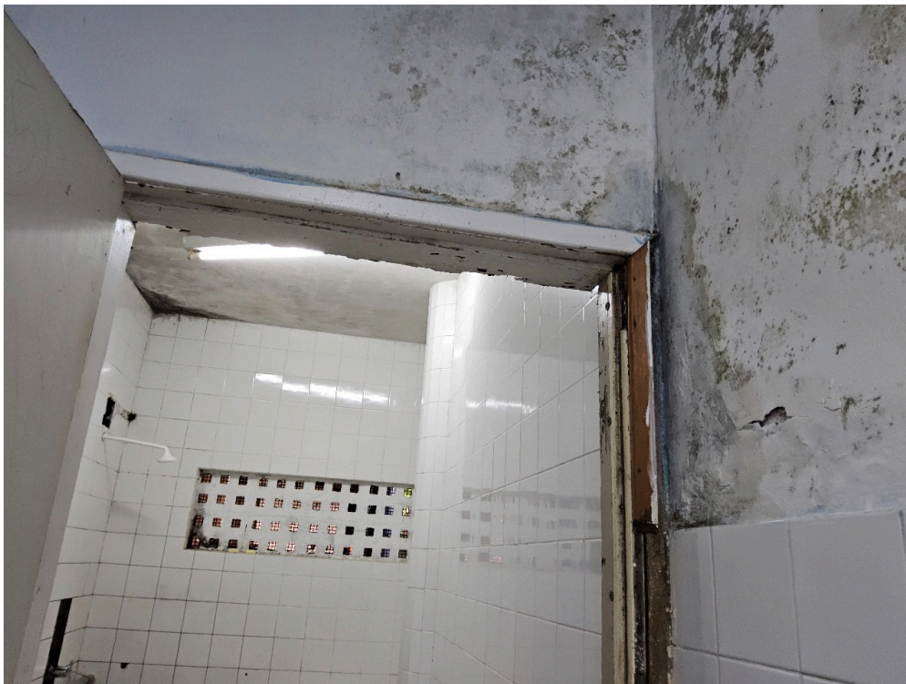
SALA DE OBSERVAÇÃO ADULTO - Sanitário anexo
