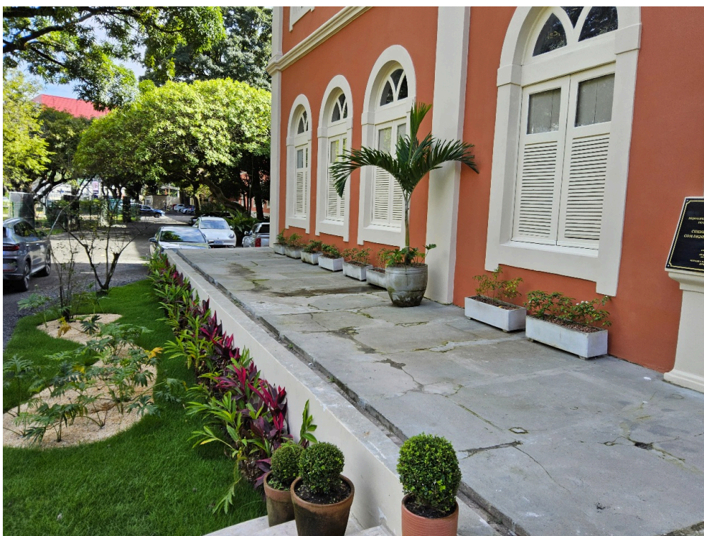
DADOS CADASTRAIS - Registro Fotográfico da Fachada
