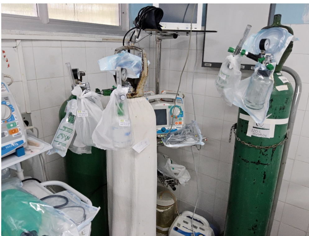
SALA DE OBSERVAÇÃO CLÍNICA - Cilindro(s)
