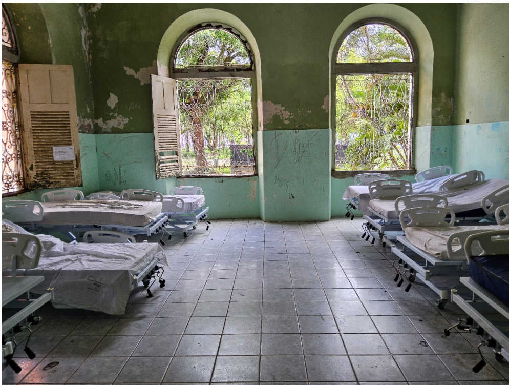
INFRAESTRUTURA - Respeita o limite de até seis leitos por enfermaria
