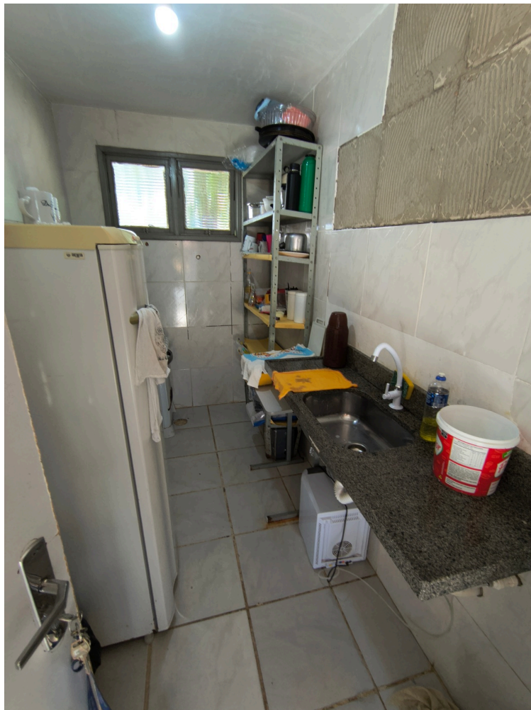
Copa/cozinha sem aeração
