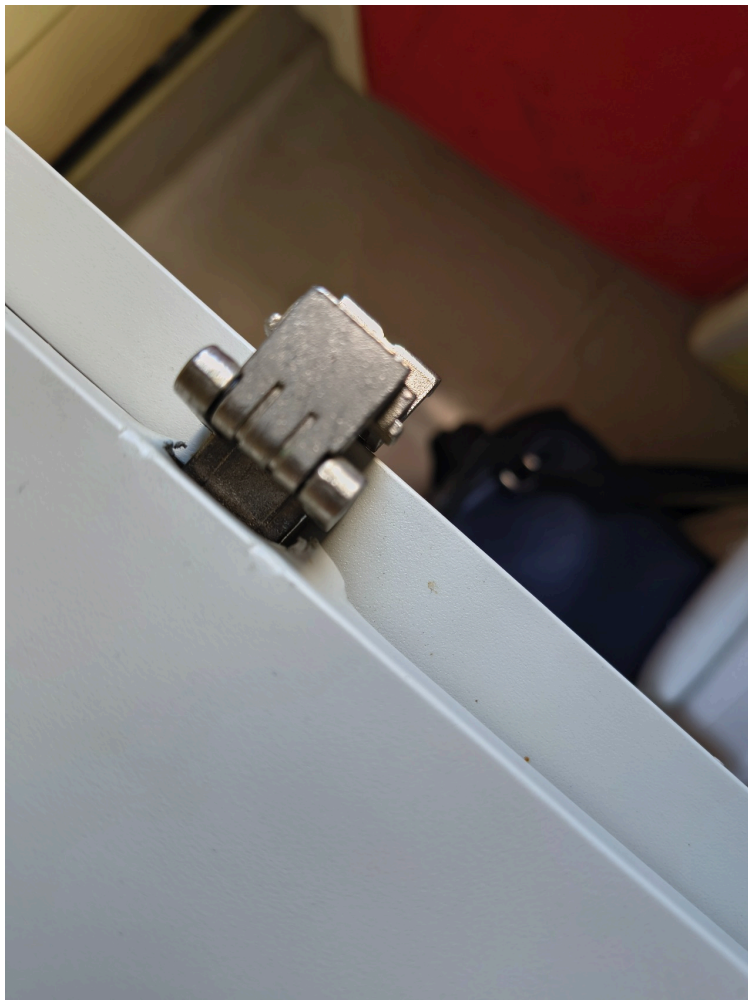
Armário com a porta quebrada no consultório da enfermagem
