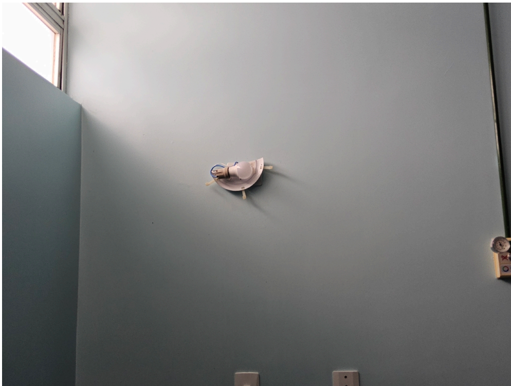
CONDIÇÕES ESTRUTURAIS DO AMBIENTE FÍSICO - GERAL - Especificar:
