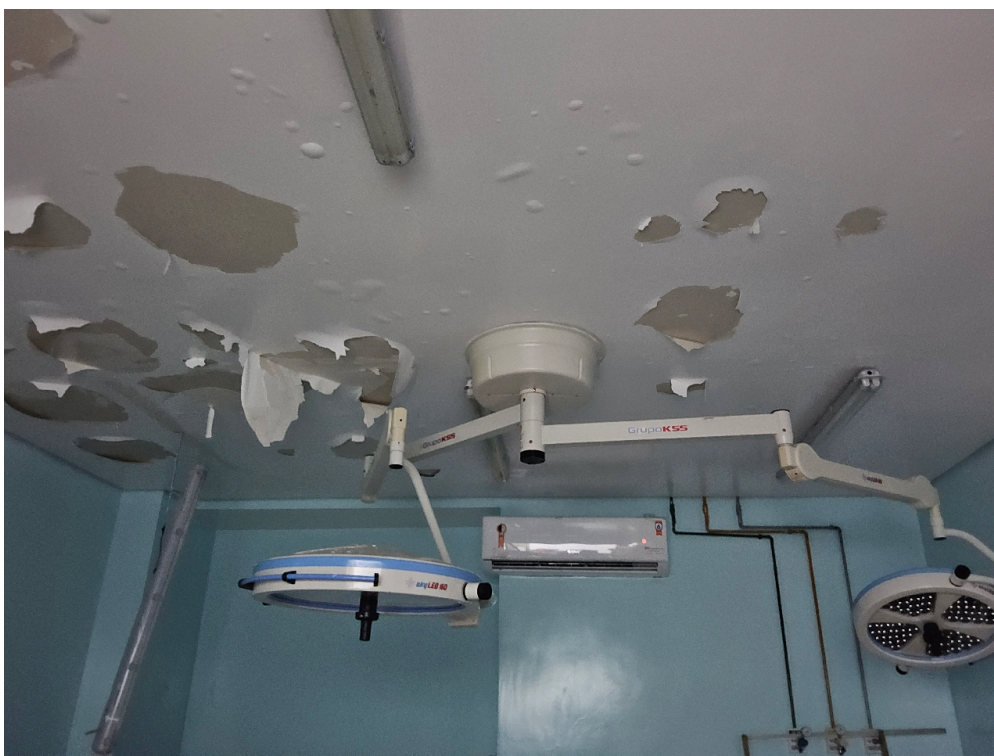
CONDIÇÕES ESTRUTURAIS DO AMBIENTE FÍSICO - GERAL - Especificar:
