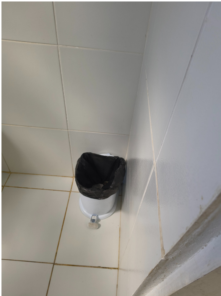
Cesto de lixo sem tampa no banheiro dos usuários
