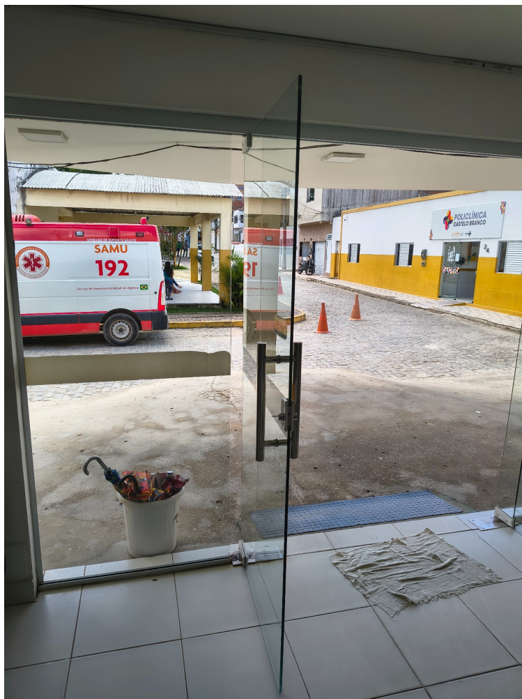
DADOS CADASTRAIS - Registro Fotográfico da Fachada
