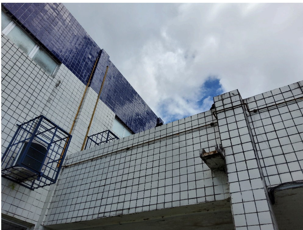
DADOS CADASTRAIS - Registro Fotográfico da Fachada
