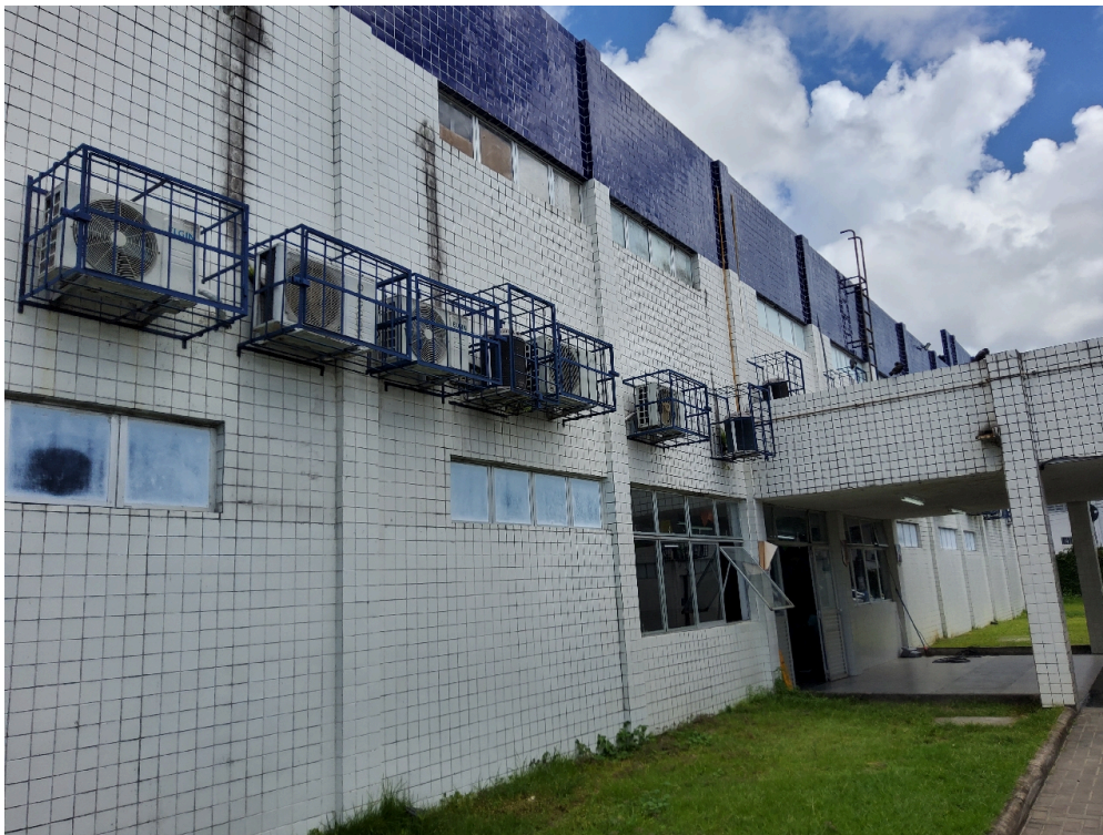
DADOS CADASTRAIS - Registro Fotográfico da Fachada
