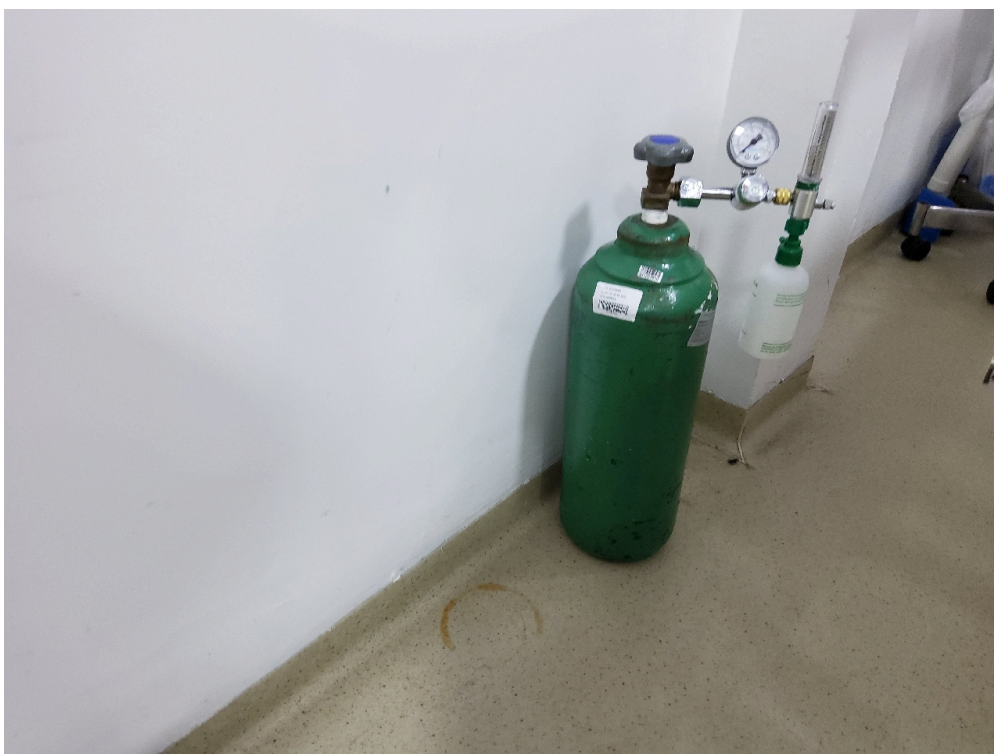
SALA DE REANIMAÇÃO E ESTABILIZAÇÃO DE PACIENTES GRAVES - Cilindro de gás medicinal sem fixação à parede ou em carrinho apropriado para armazenamento e transporte
