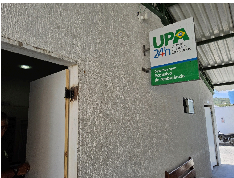
ESTRUTURA DA UNIDADE / ESPECÍFICA - A entrada da ambulância tem acesso ágil e desobstruído para a sala de reanimação e estabilização
