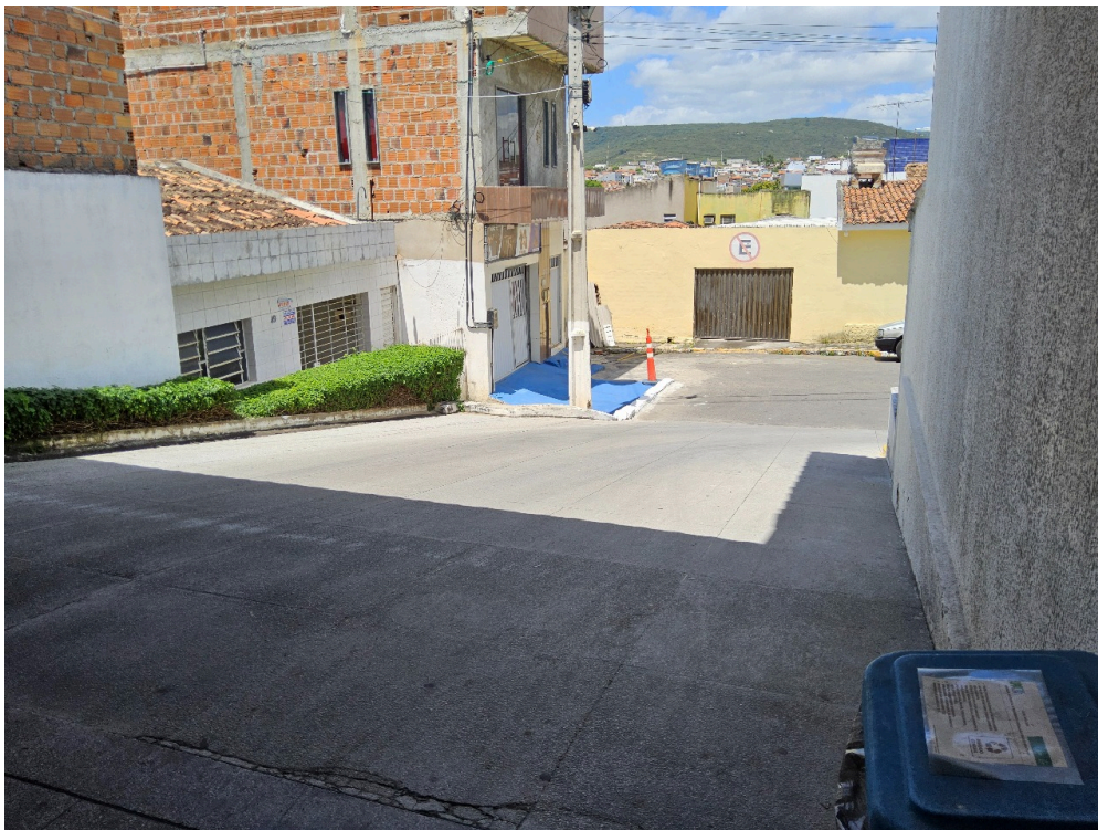
ESTRUTURA DA UNIDADE / ESPECÍFICA - Área externa para desembarque de ambulâncias é coberta
