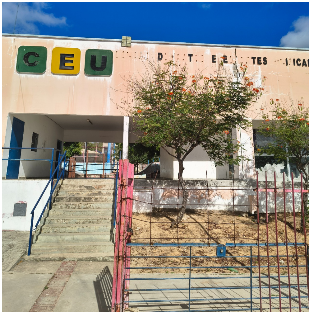
DADOS CADASTRAIS - Registro Fotográfico da Fachada
