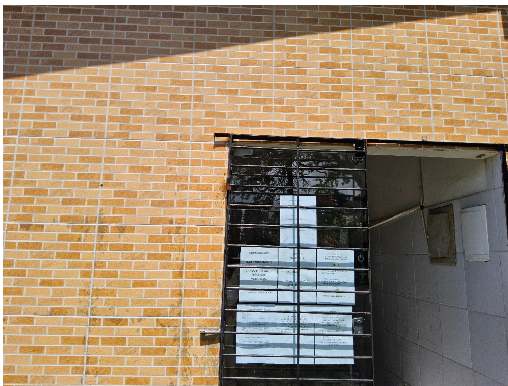
DADOS CADASTRAIS - Registro Fotográfico da Fachada
