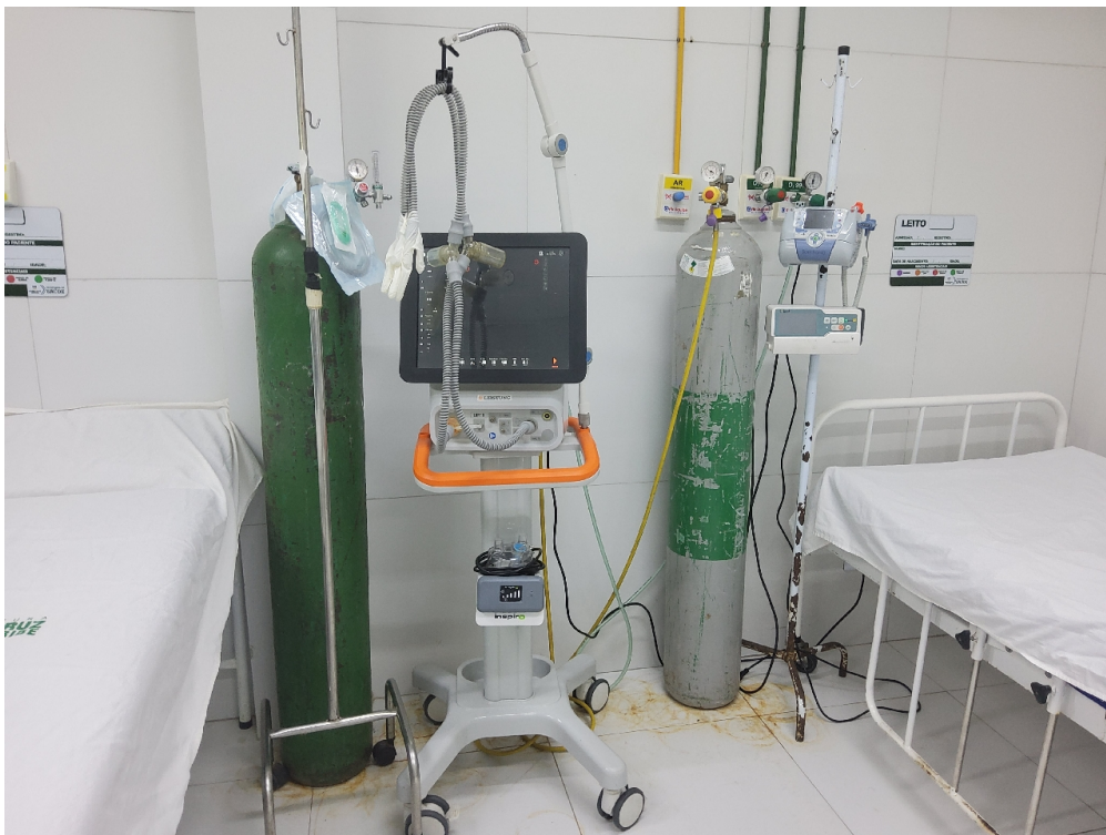
SALA VERMELHA PEDIATRIA (ventilador e torpedos de oxigênio sem fixação)
