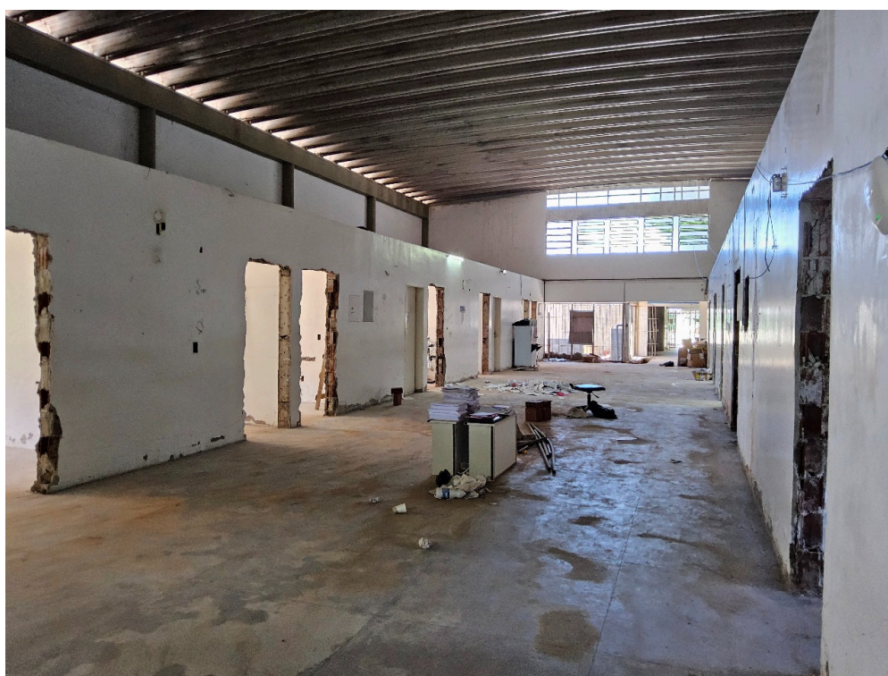
ÁREA EM REFORMA
