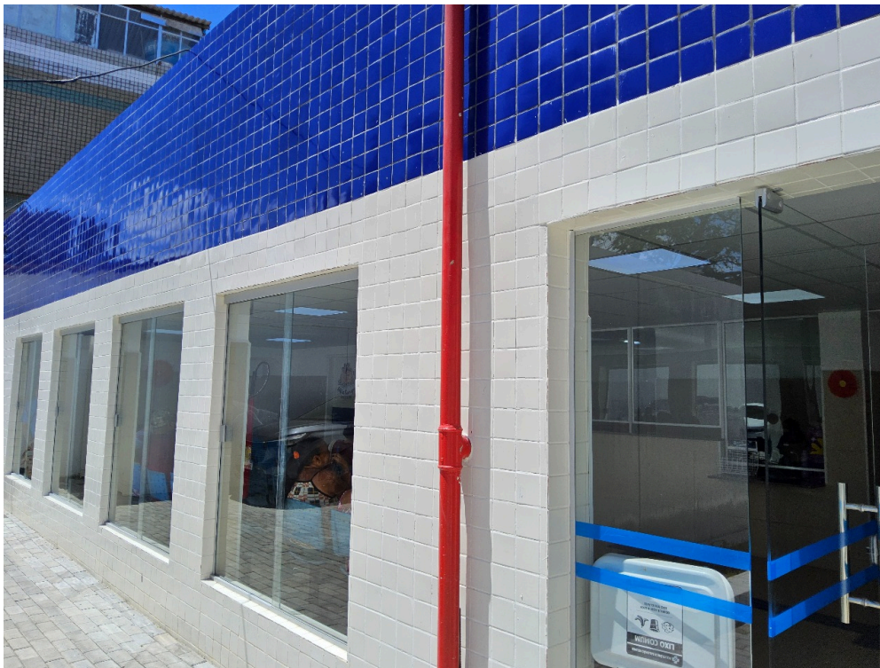
DADOS CADASTRAIS - Registro Fotográfico da Fachada
