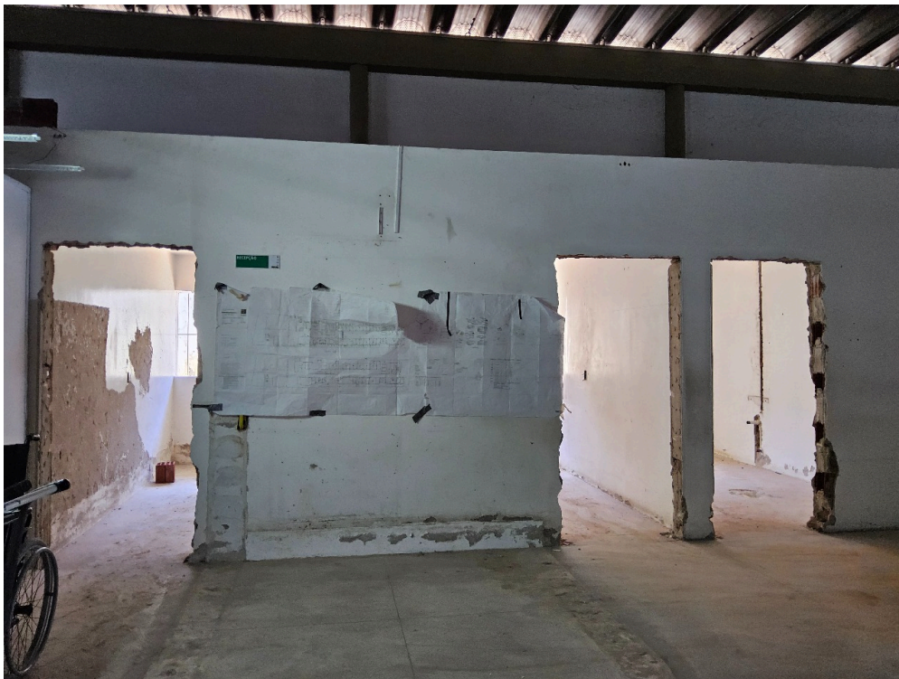
ÁREA EM REFORMA
