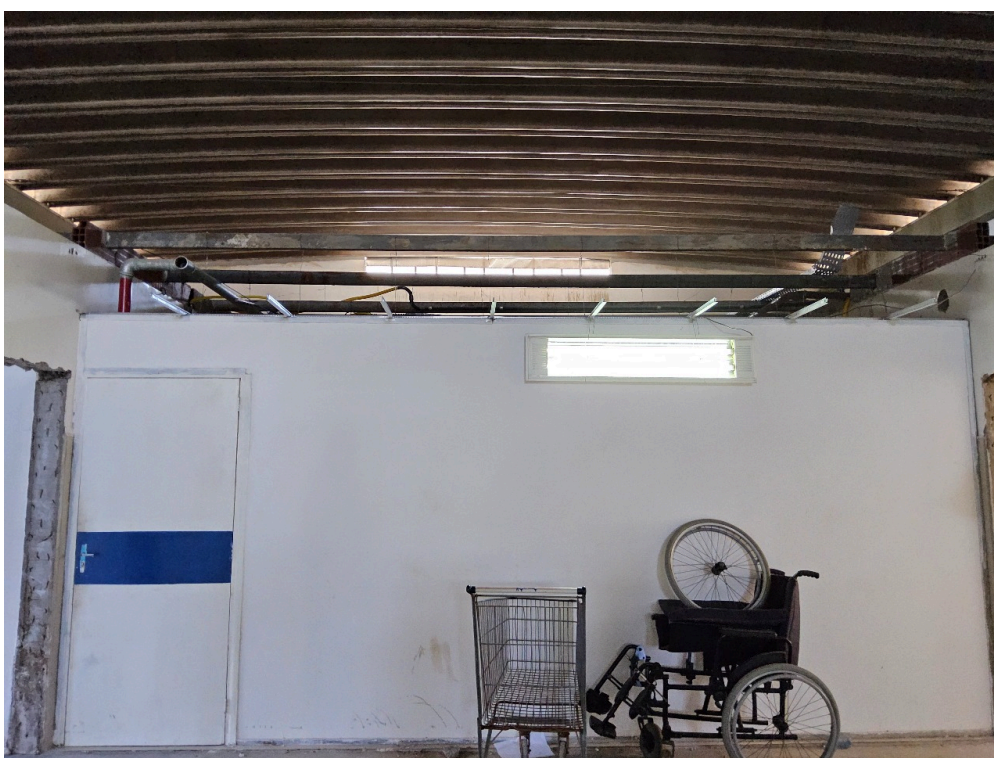
ÁREA EM REFORMA - VISÃO DA PORTA DE SEPARAÇÃO ENTRE ÁREA OPERANTE E ÁREA EM REFORMA
