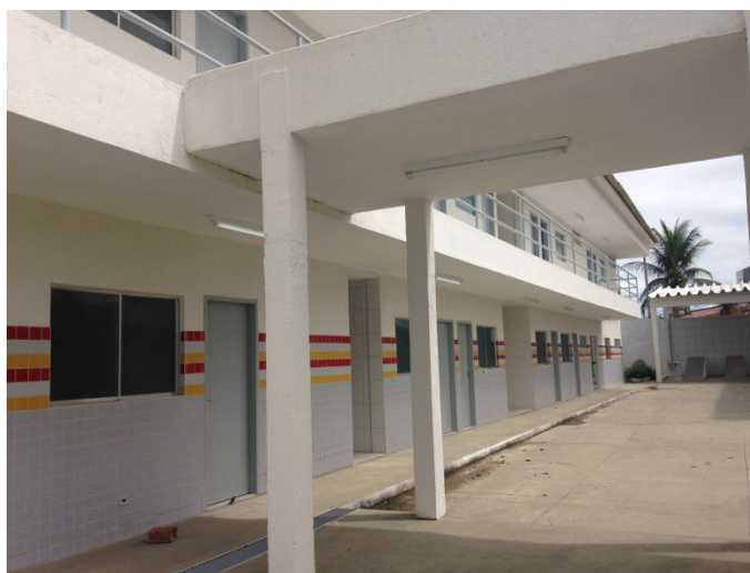
Figura 2: Novo prédio. Ao fundo rampa para lavagem das ambulâncias
