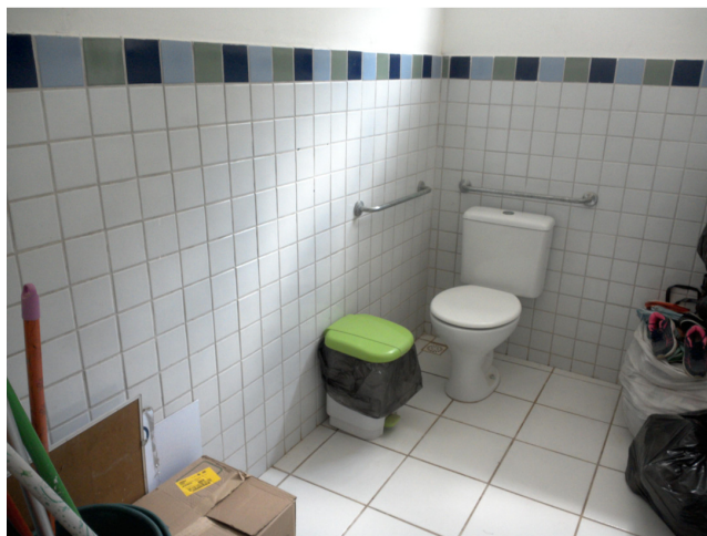
27.2. Banheiro adaptado para cadeirantes serve também para armazenar as vassouras da unidade
