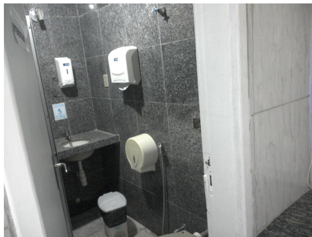
13.4. Banheiro no consultório
