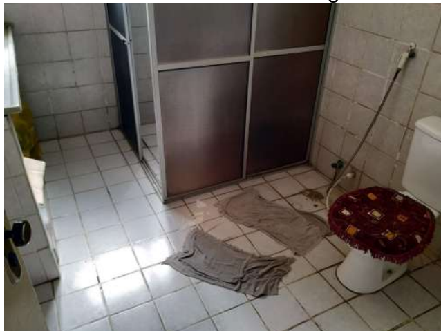
23.14. Sanitários para os funcionários
