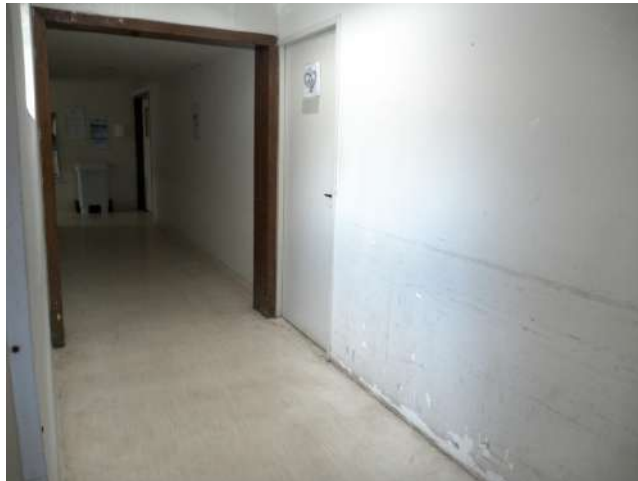
17.26. Corredor entre a UTI 3 e a UTI 2
