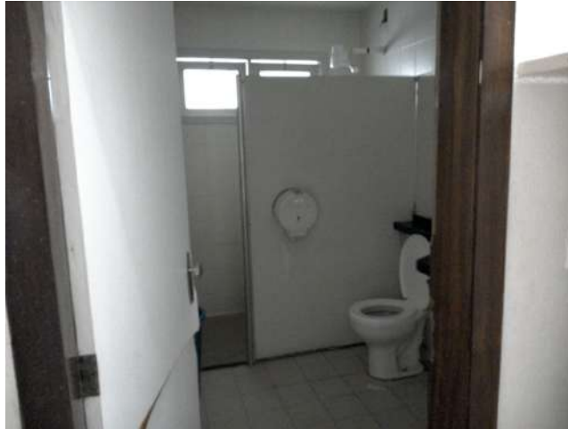
17.18. Banheiro do quarto de plantão da UTI 3 A
