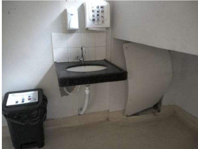
17.32. Pia na entrada da UTI 2 - Observar espaço ao lado da pia.
