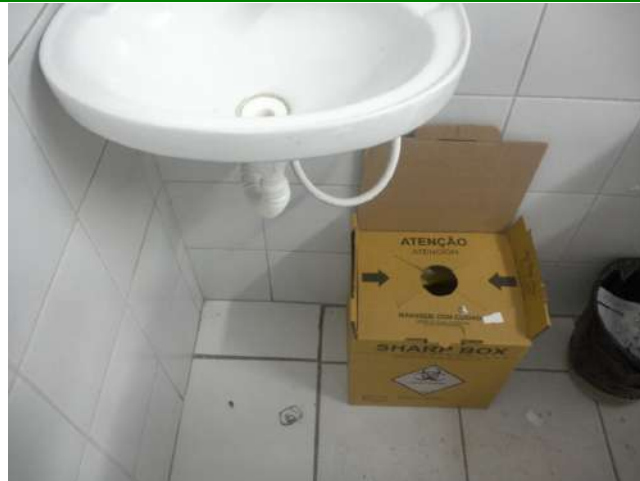
18.23. Sala de classificação de risco
