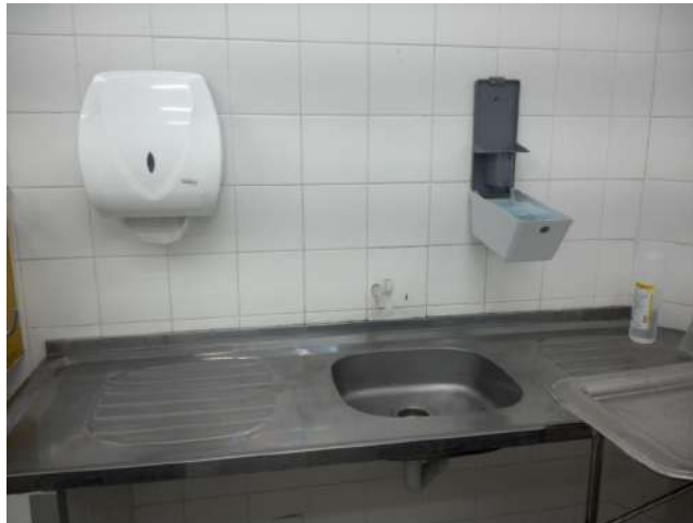
18.36. Sala de sutura - atenção ao dispensador de sabão líquido
