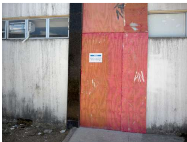
25.2. Próximo a escada de acesso a diretoria.
