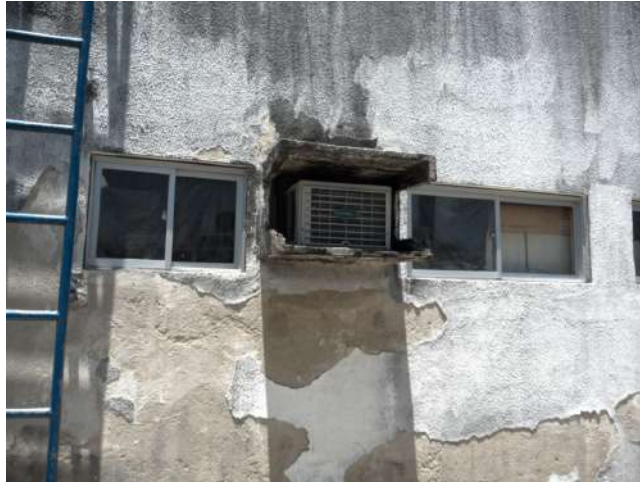
25.3. Próximo a escada de acesso a diretoria
