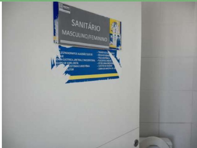
25.15. Banheiro da recepção
