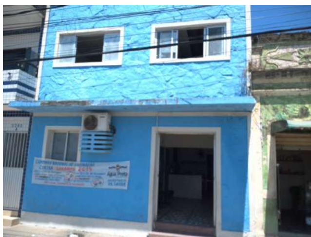
3.1. Fachada da Unidade
