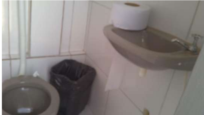
27.70. Banheiro na área externa com pia sem dispensador de sabão líquido e sem dispensador de papel toalha
