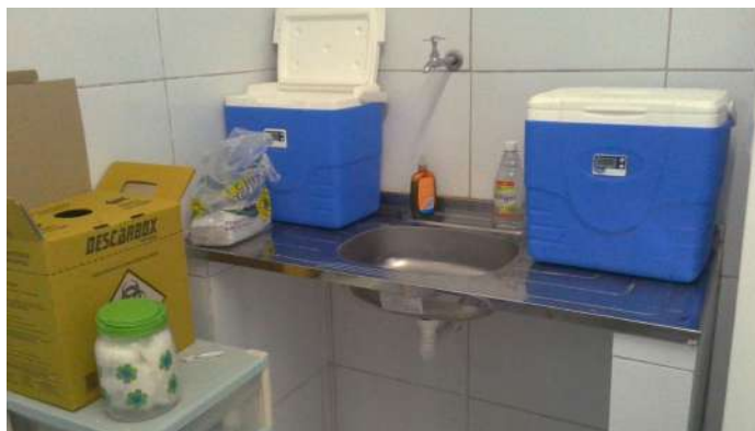
27.20. Sala de vacina - Pia sem dispensador de sabão líquido nem dispensador de papel toalha
