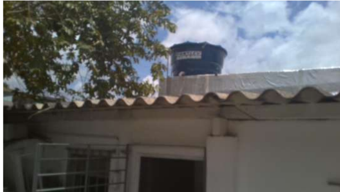
27.76. Área externa - telhado
