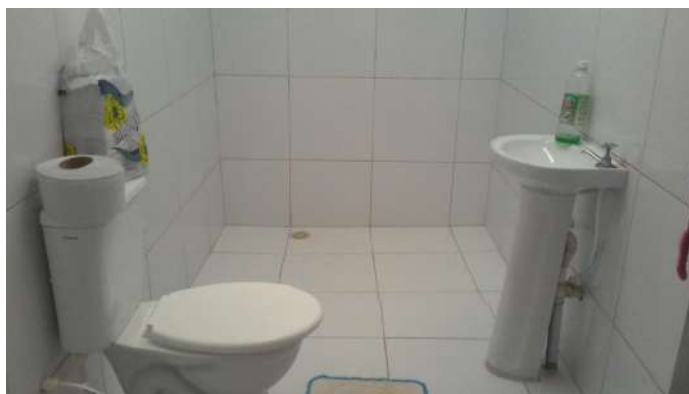
27.39. Banheiro dos funcionários - observar degrau na entrada além de pia sem dispensador de sabão líquido e sem dispensador de papel toalha.
