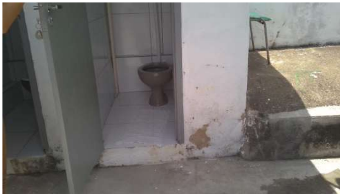
27.68. Banheiro na área externa - Observar degrau de acesso
