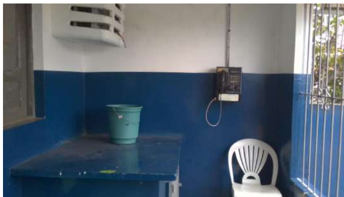
27.5. Terraço na entrada da unidade
