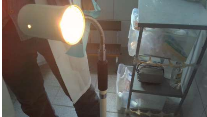
27.37. Consultório 01 - foco luminoso funcionando
