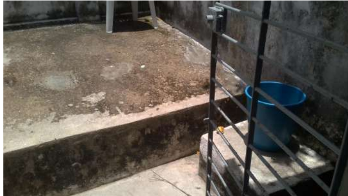
27.64. Porta para área externa - acesso ao banheiro dos pacientes
