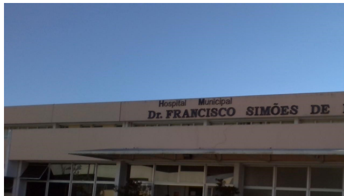
25.1. Fachada do hospital
