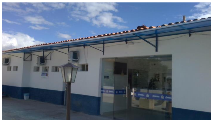
22.1. Fachada do hospital
