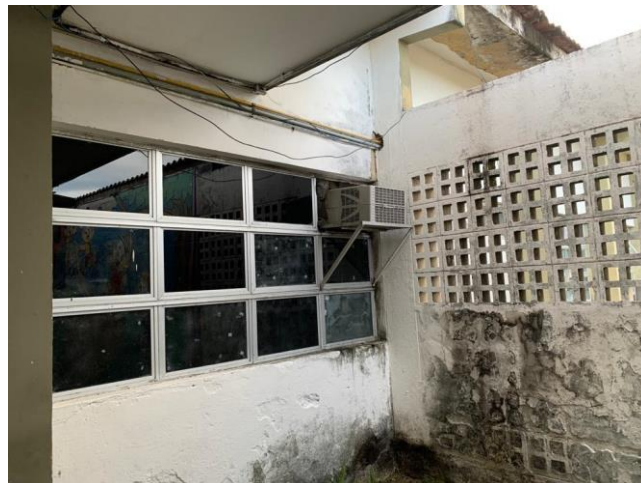
29.14. Infiltração Mofo
