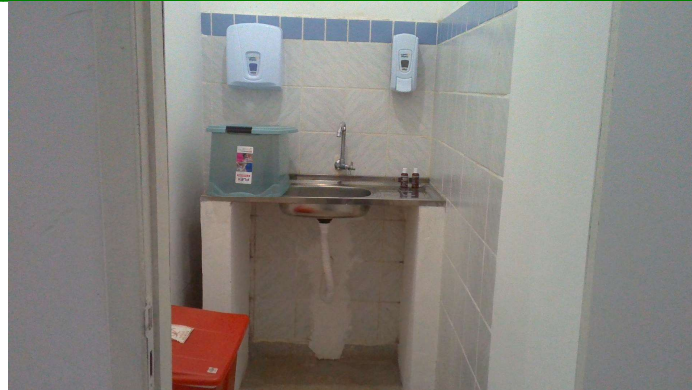
15.25. Sala de desparamentação 2
