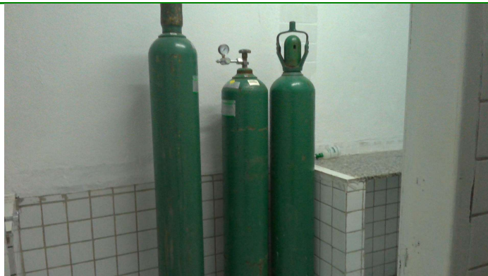
27.16. Local para armazenamento de cilindros de oxigênio
