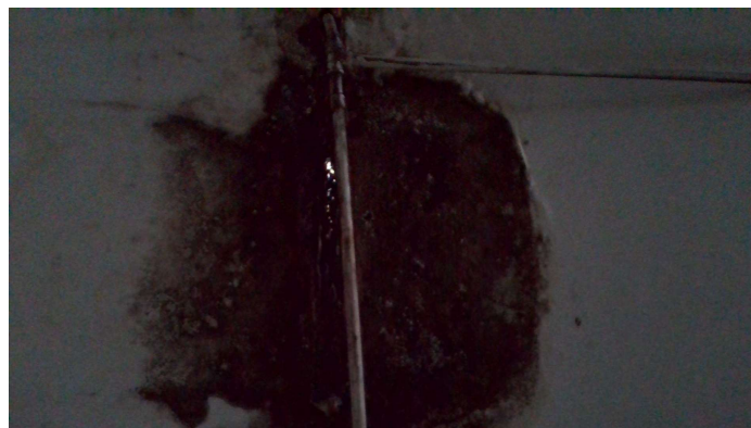
23.27. Vazamento do ar condicionado
