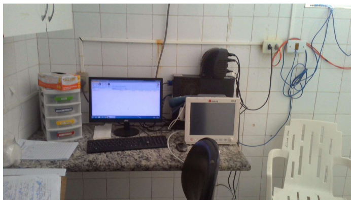
35.30. Sala de classificação de risco (emergência geral)
