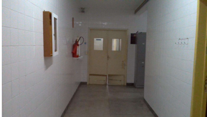
35.16. Acesso ao bloco cirúrgico
