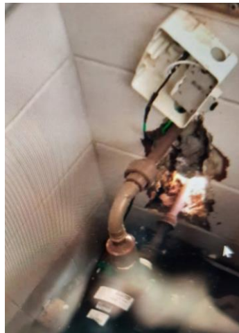
32.5. Instalações prediais livres de trincas, rachaduras, mofos e/ou infiltrações
