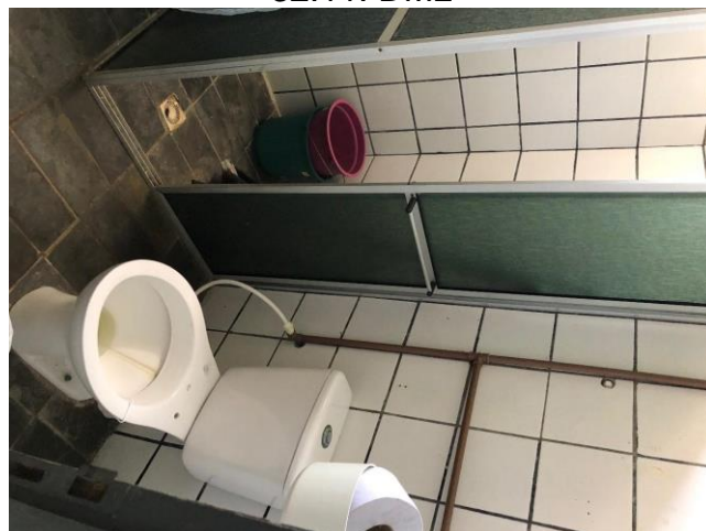
32.12. Sanitários para os funcionários
