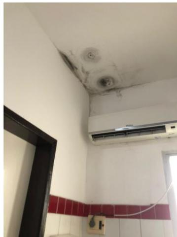
**26.37. Triagem ( Mofo e infiltração)**
