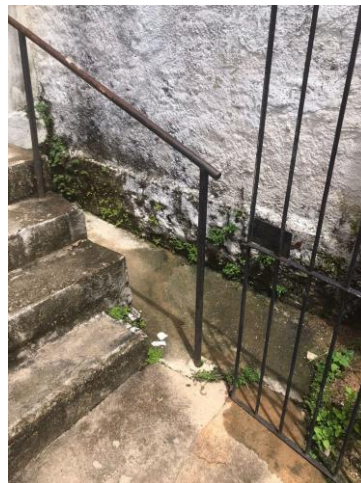
30.9. Há vazamento de fossa do vizinho para dentro da entrada da unidade
