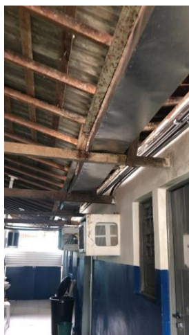
33.19. Calha no espaço interno da unidade
