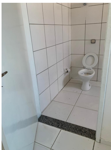
34.52. Sala sem funcionar
