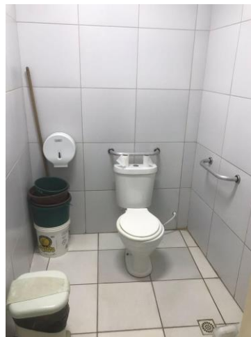
26.2. Banheiro público com Barra de segurança e espaço para cadeirantes
