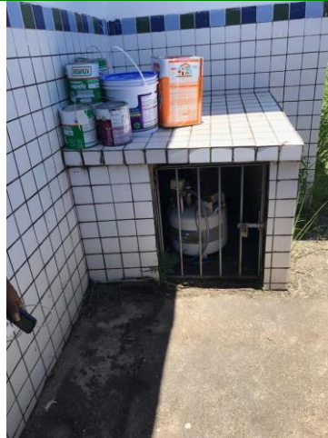
33.13. Sala (abrigo) de Compressor Odontológico
