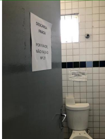
33.7. Sanitários para os funcionários
