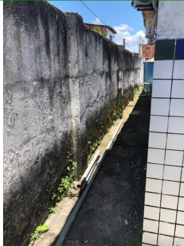
33.25. Instalações elétricas incompatíveis com a segurança do paciente
