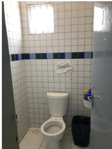
33.23. Sanitários para usuários com vaso sem tampa e materiais DML
