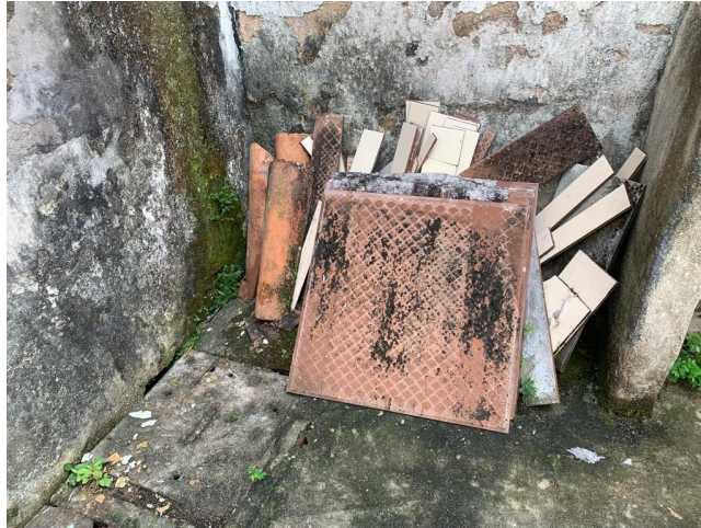
35.43. Lavanderia e entulhos
