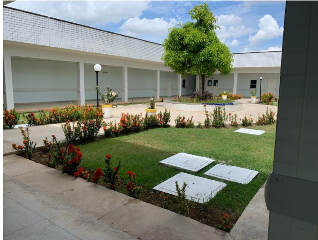
44.73. Area Interna Corredores
