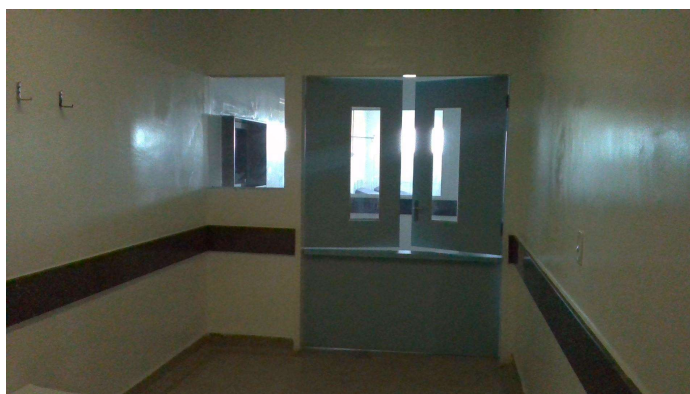
33.24. Entrada do bloco cirúrgico
