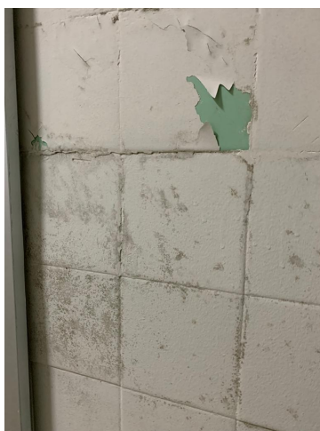
33.67. Sinais de Infiltração e Mofo
