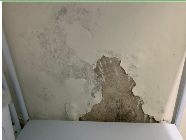
33.96. Sala de Parto Sinais de Infiltração e Mofo
