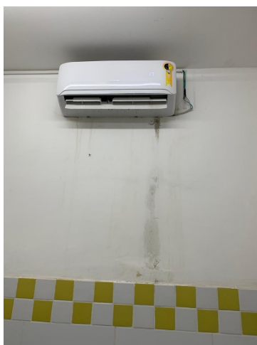
36.37. Consultorio Medico Sinais de Infiltração e Mofo
