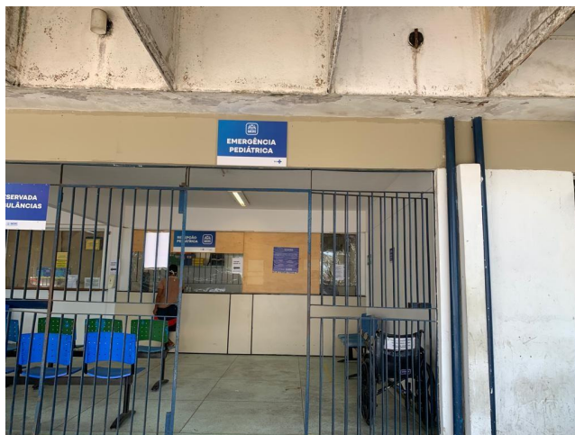
29.109. Entrada Emergencia Pediatrica
