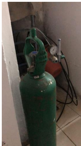
36.35. Cilindro de Oxigênio sem fixação, no Depósito de Material de Limpeza (DML)
