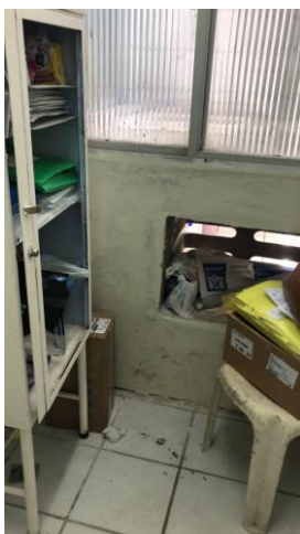
36.53. Sala sem uso, com caixa de ar condicionado vazia
